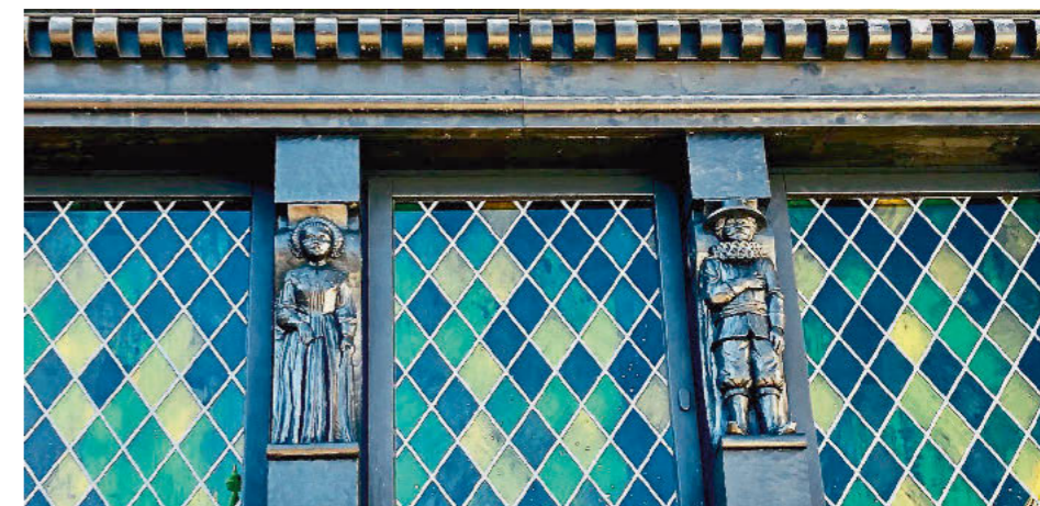
Foto: Boschert Innenausbau
